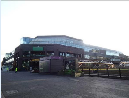
施設全景 全英オープンテニスの大会期間中のみ使用される。
