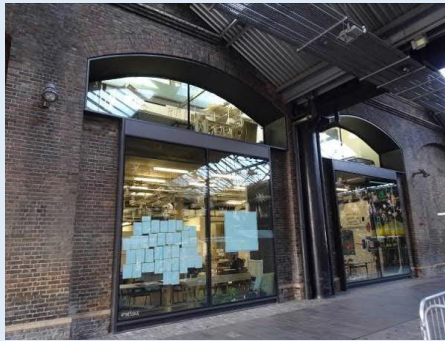
レンガ倉庫のスーパー 古いレンガ倉庫を改修して、スーパーとして活用。
