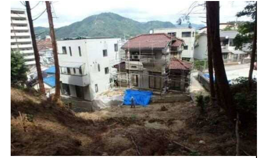
斜面崩壊・被災状況（H30年7月）
