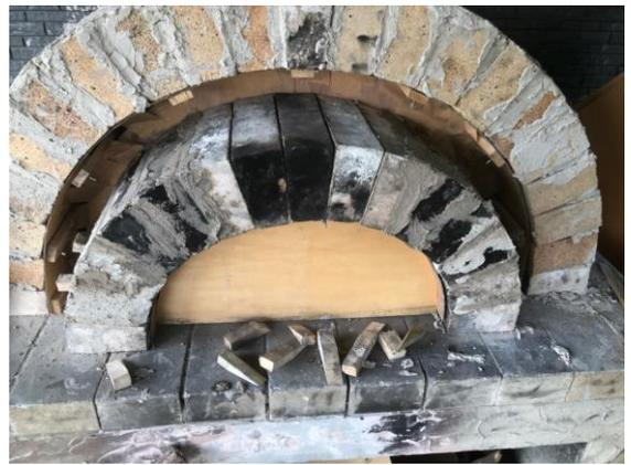
レンガの間にモルタルを詰める作業は、角度を測って作った大量のくさびを打ち込み、ケーキの生クリーム絞りの要領で目地を埋めていった。
