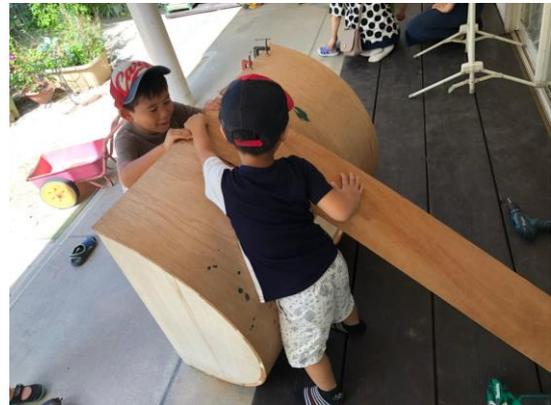
2代目も同じかまぼこ型を選択。取り壊しとほぼ同時に、窯の空間の型を作っていく。手伝ってくれる子どもたちは大変頼もしいが、強いテンションがかかった状態の板は大変危険なので、そうした作業の時は、少し距離を置いて見守るように指示。釘だと反り返ろうとする力で抜けてしまうので、ネジを何本も使用。
