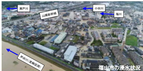
福山市の浸水状況
