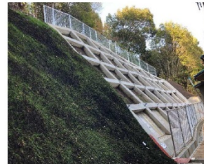
工事完了（令和2年4月18日）
