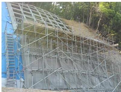
県急傾斜事業 矢野西3丁目37地区 (広島市安芸区)
