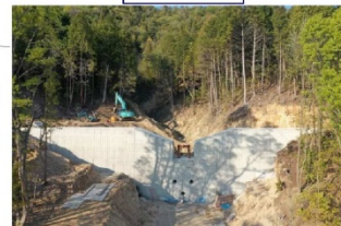
工事了（令和2年4月30日）
