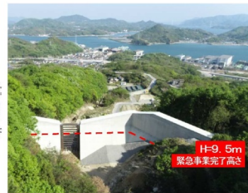
工事了（令和2年4月30日）
