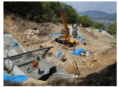
県治山事業 笹原地区 (広島市安佐北区)
