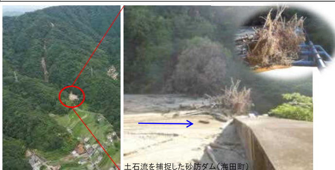
土石流を捕捉した砂防ダム(海田町)
