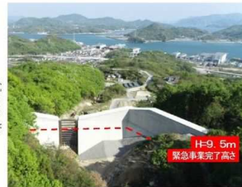
工事了（令和2年4月30日）
