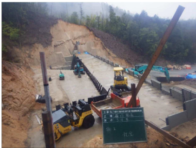
県砂防事業 : 杉坂下川隣 (東広島市志和町)
