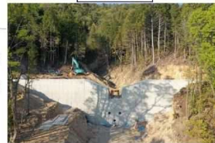
工事了（令和2年4月30日）
