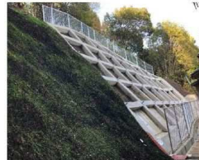
工事完了（令和2年4月18日）
