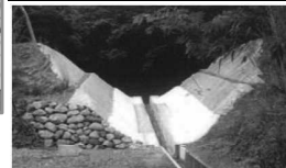
◀利用しなくなったため池の廃止工事▶
