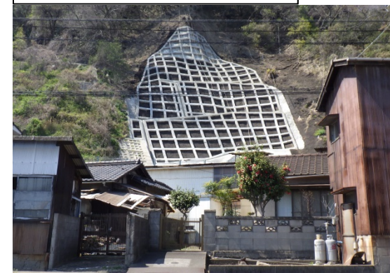
工事完了（令和2年3月27日）
