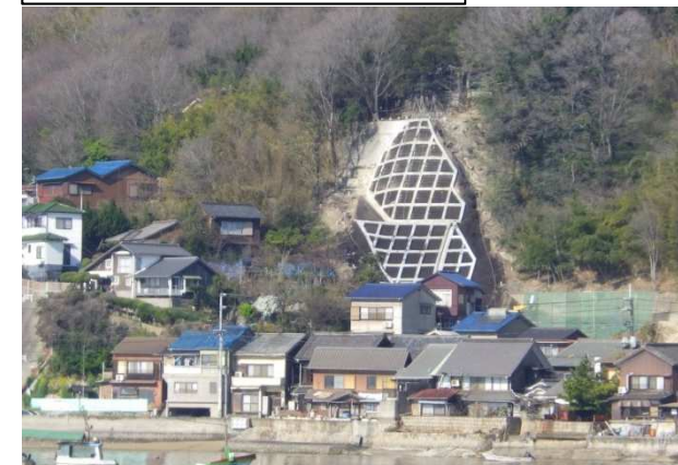
工事完了(令和2年3月27日)
