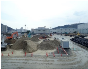
二次仮置場（坂町）処理中
