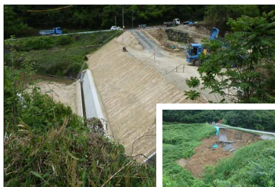
ため池の復旧工事状況（福山市）
