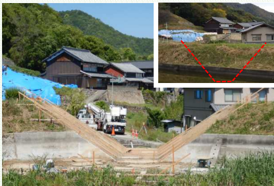
廃止工事の状況（三原市）
