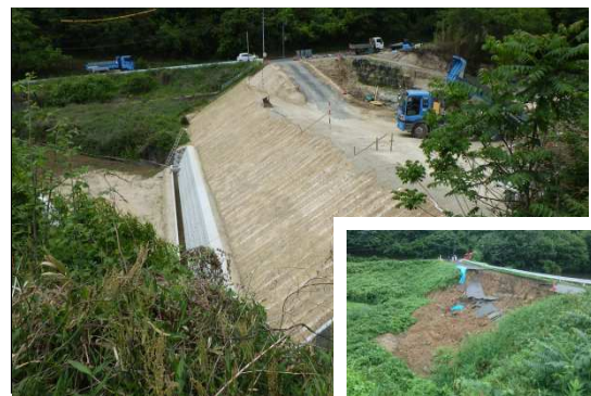
ため池の復旧工事状況（福山市）
