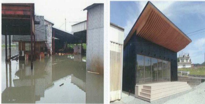
(復旧前) (復旧後) 新事業チャレンジ(グループ補助金)の状況(製造業) 製造工場にショールームを兼ねた作業場を新築
