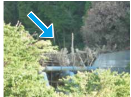
平成30年7月豪雨直後の様子 流れてきた土石や木を食い止めて、被害を防止
