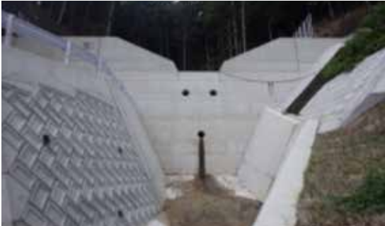
砂防堰堤(土石流対策)
