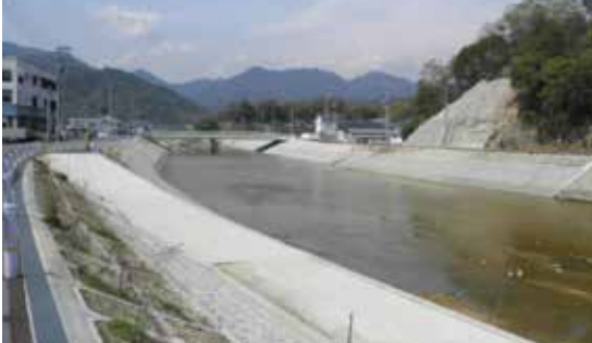
河川改修(河道拡幅)
