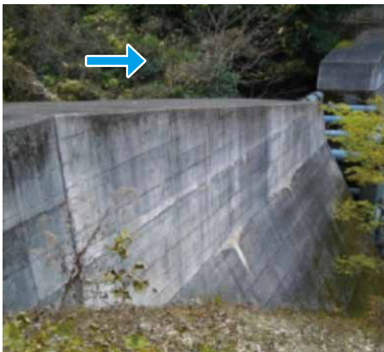
発災前の砂防堰堤
