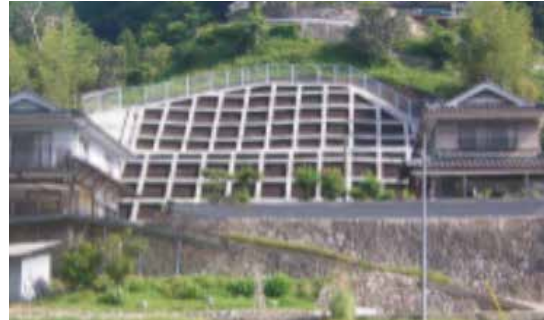
急傾斜地崩壊防止施設(がけ崩れ対策)
