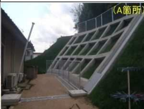
工事完了（令和2年5月22日）
