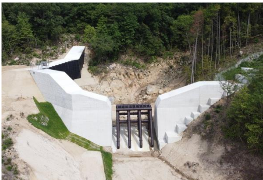
砂防指定地内河川 二河川支川2 1 災害関連緊急砂防事業 (熊野町川角)
