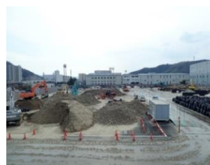
二次仮置場（坂町）処理中
