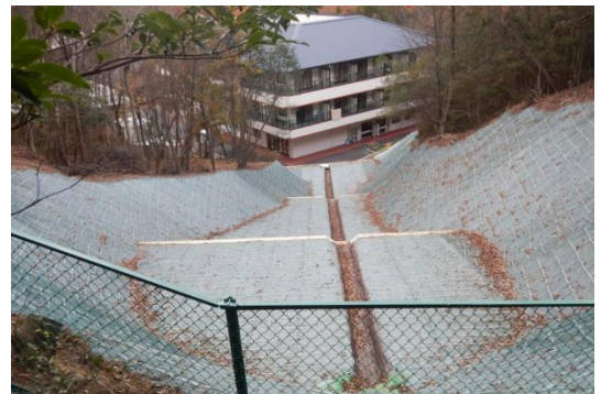
災害関連緊急治山事業 (東広島市)
