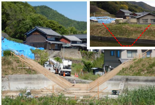
廃止工事の状況（三原市）
