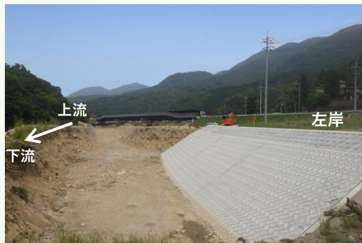
一級河川太田川水系 三篠川 災害復旧助成事業 (広島市安佐北区白木町地内)
