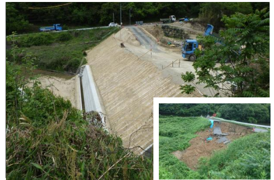
ため池の復旧工事状況（福山市）
