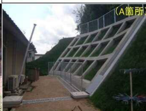
工事完了（令和2年5月22日）
