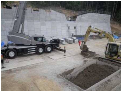
県砂防事業：頭谷川2隣 (三原市大和町)
