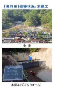
【東谷川】進捗状況:本土工
