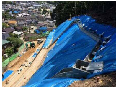
県急傾斜事業：下為角4111地区 (広島市安芸区)
