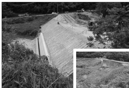
ため池の復旧工事状況（福山市）
