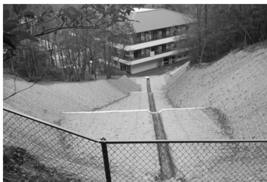
災害関連緊急治山事業 (東広島市)
