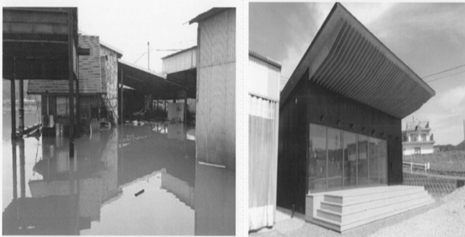
(復旧前) (復旧後) 新事業チャレンジ(グループ補助金)の状況(製造業) 製造工場にショールームを兼ねた作業場を新築
