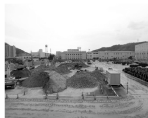
二次仮置場（坂町）処理中
