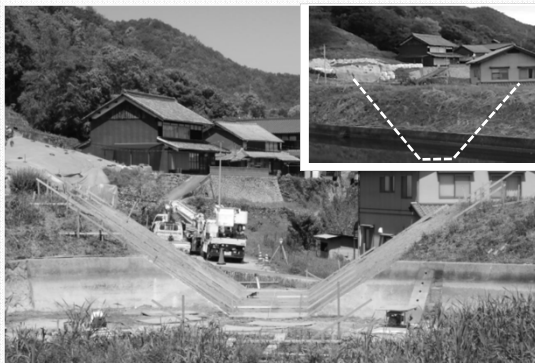
廃止工事の状況（三原市）
