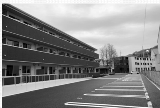
災害公営住宅（坂町）
