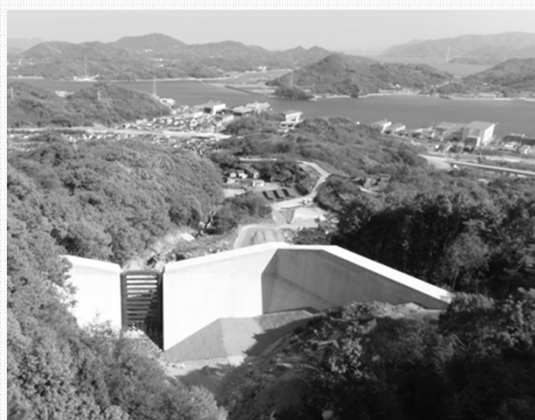
砂防指定地内河川 西福地川 災害関連緊急砂防事業 (三原市木原6丁目)
