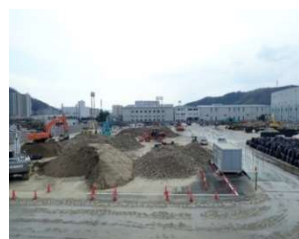
二次仮置場（坂町）処理中
