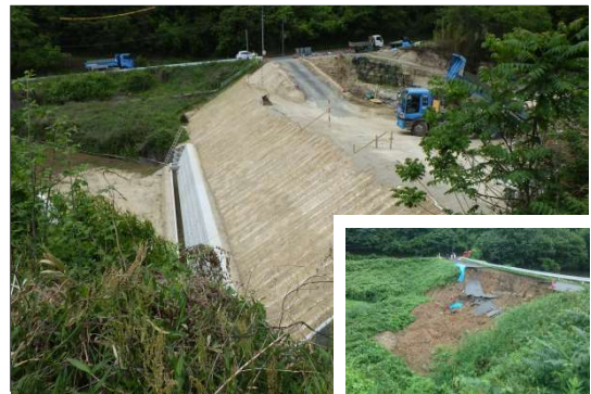
ため池の復旧工事状況（福山市）
