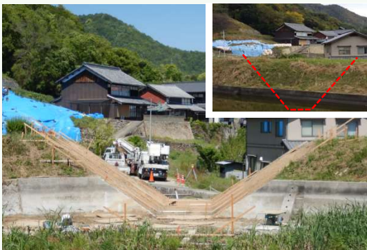
廃止工事の状況（三原市）
