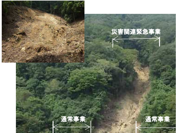
工事着手時（伐採後）
