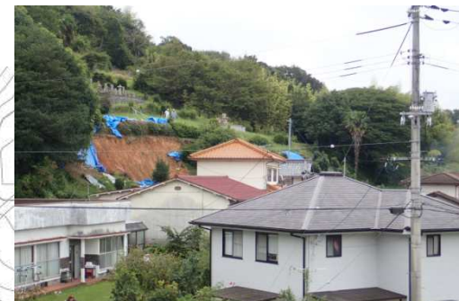
斜面崩壊・被災状況（H30年7月）
