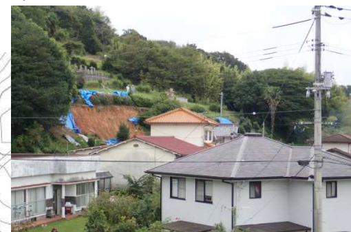
斜面崩壊・被災状況（H30年7月）
