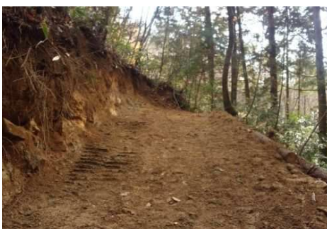
作業道を開設した後の様子
