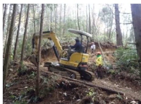
バックホウを用いて、掘削する様子
