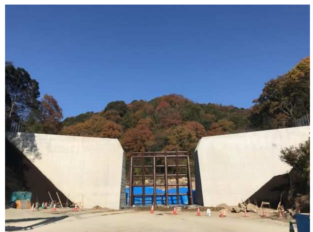
坂町小屋浦地区砂防ダムの完成（天地川）
