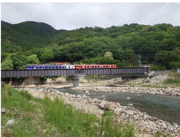
三篠川橋梁復旧工事の完成
