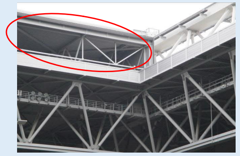
開閉式の屋根 屋根を閉じて展示場として使用することもある。
