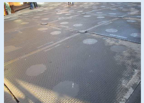
クリスマスマーケット 園内には、歩行空間だけでなく、仮設建物の下にもゴム製の仮設床材が敷き詰められていた。
