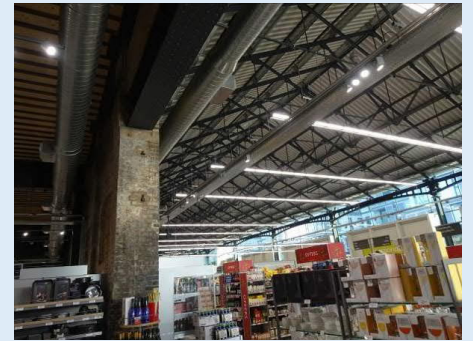
スーパー内部 古い柱や壁、扉などが残されていた。
