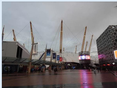
施設外観 マスト(黄色の支柱)と膜屋根で覆われた特徴的なデザイン。
