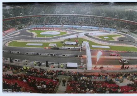
多目的利用 ピッチの多目的利用では、コンサートだけでなくカーレースを実施するなど、多彩なイベントに活用。
