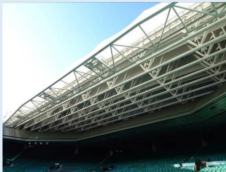
開閉式の屋根 会員等からの要望により、2009年に設置。
