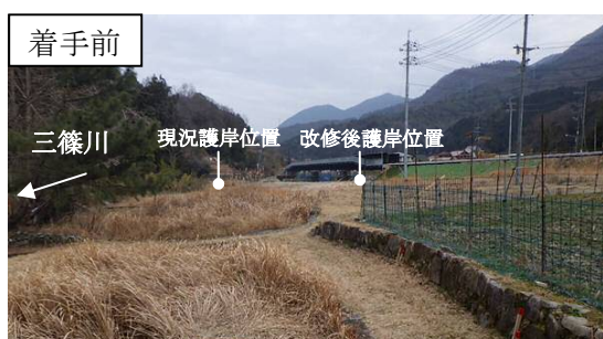
《三篠川【災害復旧助成事業】の進捗状況》
