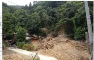
斜面崩壊・被災状況 (H30年7月)
