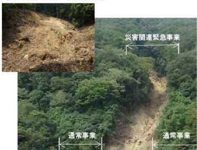
工事着手時（伐採後）
