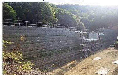
工事完了（令和2年6月1日）
