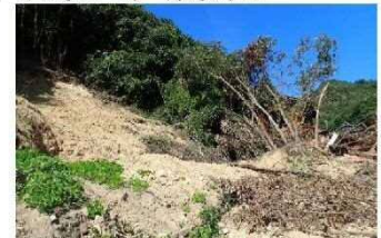
斜面崩壊・被災状況（H30年7月）
