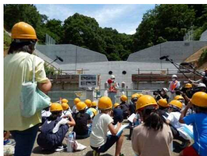
【7/2 天地川支川5 小学生に対する現場見学】
