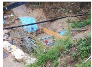
県治山事業 水ヶ浦地区 (江田島市江田島町)
