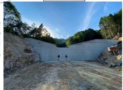
工事完了（令和2年6月30日）
