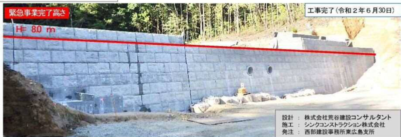
工事完了（令和2年6月30日）
