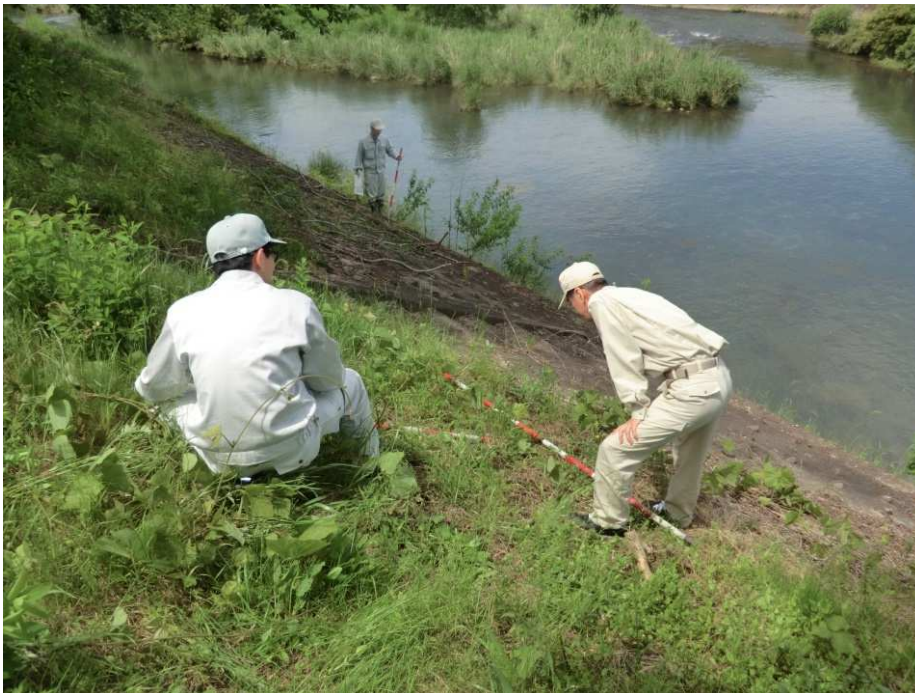
堤防点検の様子（馬洗川）
