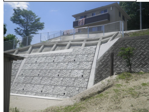
工事完了（令和2年7月28日）
