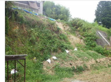
斜面崩壊・被災状況（平成30年8月）
