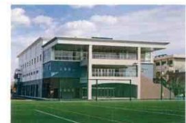
2019年春完成、冷暖房完備の新体育館
