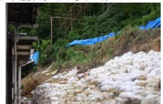
斜面崩壊・被災状況（H30年7月）
