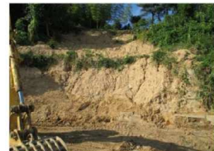
斜面崩壊・被災状況（H30年7月）
