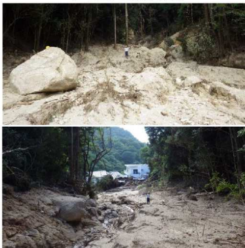
【工事前の荒廃状況】
