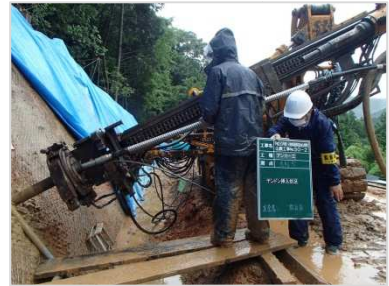
県治山事業 保垣地区 (安芸高田市向原町)
