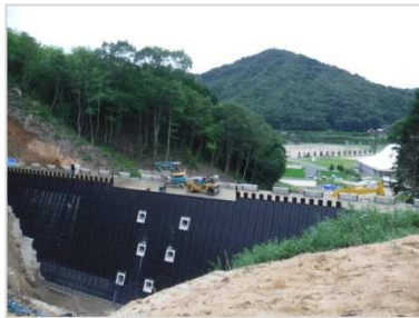
県砂防事業 東川 (三原市大和町)
