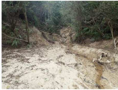
【工事前の荒廃状況】
