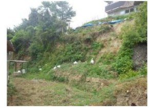
斜面崩壊・被災状況（平成30年8月）
