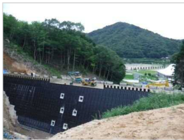
県砂防事業 東川 (三原市大和町)
