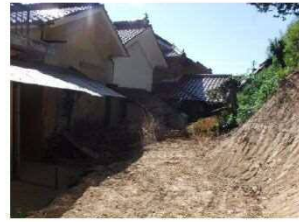
斜面崩壊・被災状況（H30年7月）
