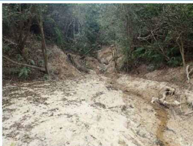
【工事前の荒廃状況】
