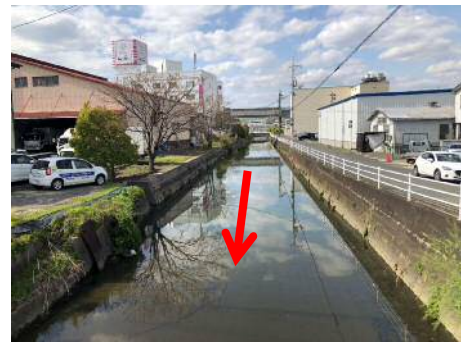
中流域工事 (福山市引野町)
