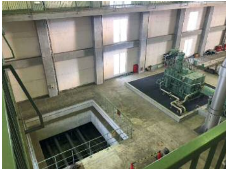
ポンプ増設工事 (手城川排水機場内)
