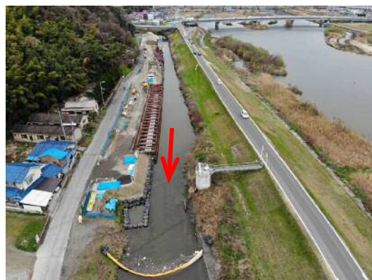
用水管渠敷設工事
