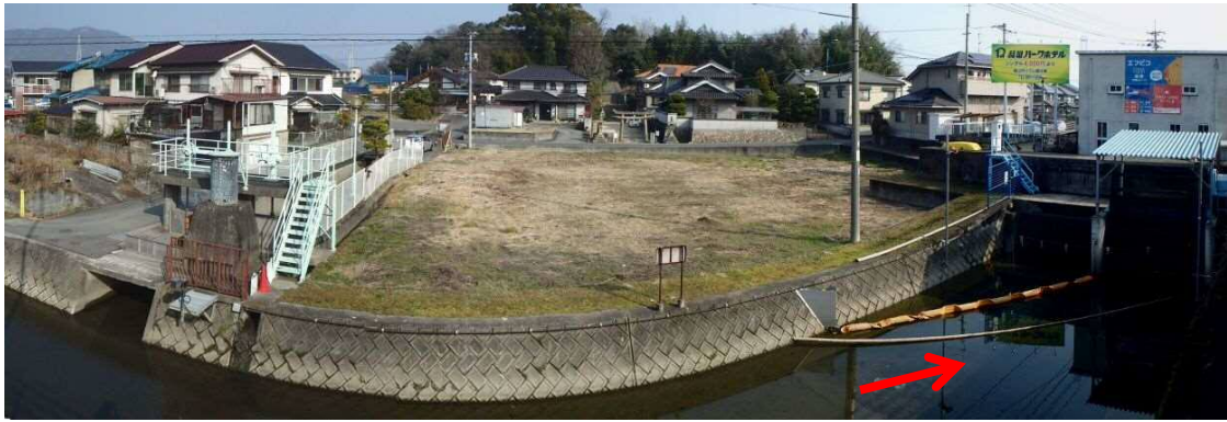
(仮称) 福川排水機場 (福山市神島町)
