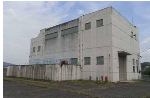
古市排水ポンプ場
