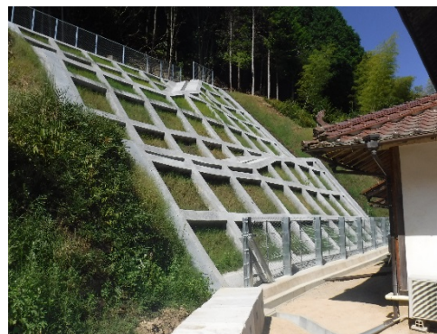
工事完了（令和2年8月31日）
