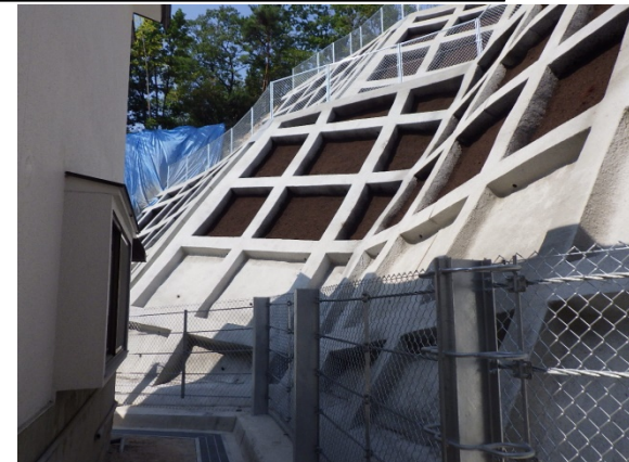
工事完了（令和2年9月11日）
