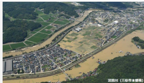
平成30年7月豪雨 被害状況（三原市）
