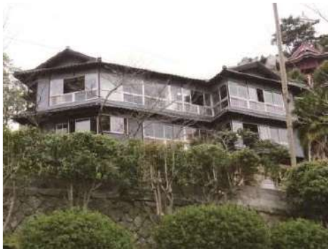
写真 3-9 再生された空き家(尾道市)
