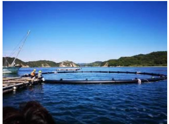
図3 試作した円形 PE 管製かき養殖筏
