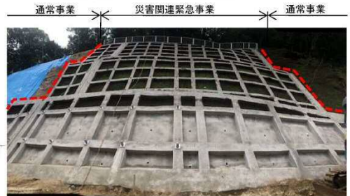
工事完了（令和2年8月11日）
