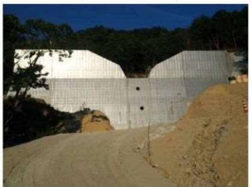
工事完了（令和2年8月31日）
