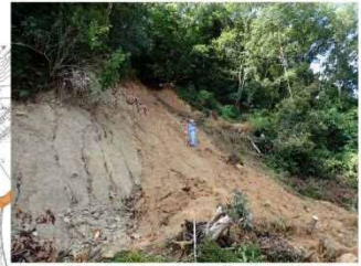
斜面崩壊・被災状況（H30年7月）
