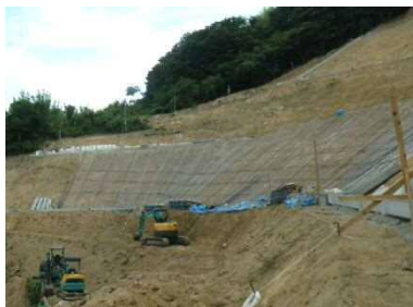
県急傾斜事業 大君地区 (江田島市大柿町)
