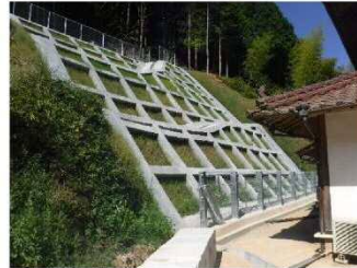
工事完了（令和2年8月31日）
