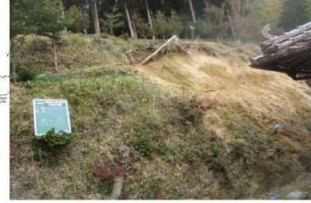
斜面崩壊・被災状況（H30年7月）
