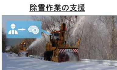
除雪作業の支援 経験が浅いオペレーターでも作業を行うことが可能となる除雪支援技術の構築
