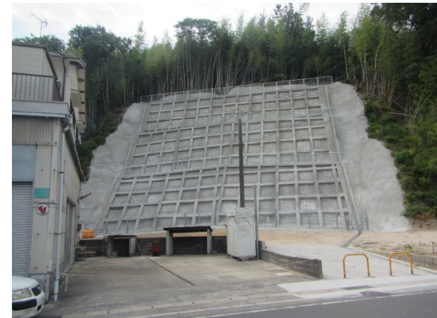
工事完了（令和2年9月30日）
