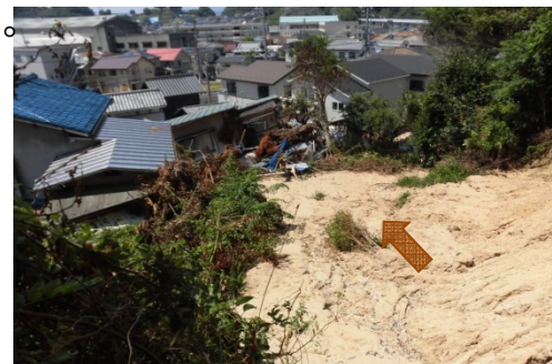
斜面崩壊・被災状況（H30年7月）
