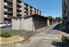
敷地全体が舗装された既存環境
