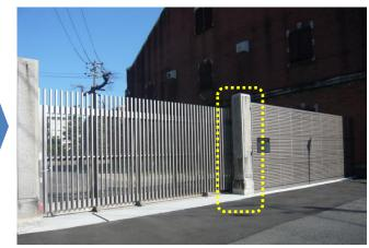
※ 折れた門柱が鉄枠固定により復元されていたが、危険なため、一旦撤去した上で、内部にステンレス鋼の芯棒を挿入して補強し、元の位置に再設置した。
