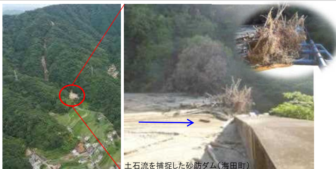
土石流を捕捉した砂防ダム(海田町)
