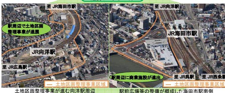
土地区画整理事業が進む向洋駅周辺
