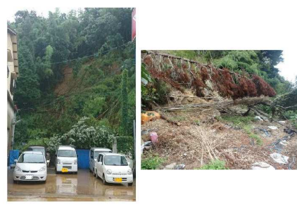
斜面崩壊・被災状況（平成30年7月）
