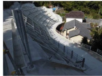
工事完了（令和2年9月30日）
