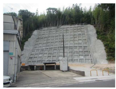
工事完了（令和2年9月30日）
