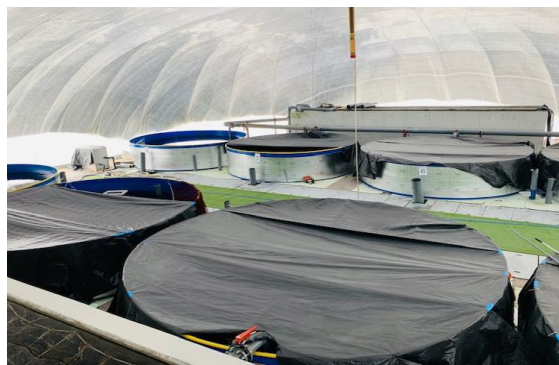
20トン水槽8基設置
