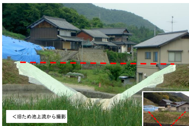
ため池の廃止工事状況
