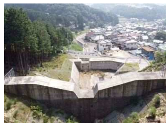
県砂防事業 根谷川支川101 (安佐北区可部東6丁目)
